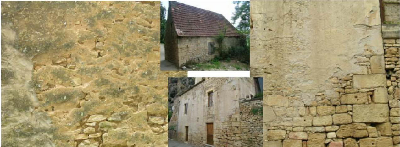
Enduit à la chaux naturelle et sable de carrière à grain fin. La tonalité ocre du sable, proche de la couleur de la pierre, est soutenue.
